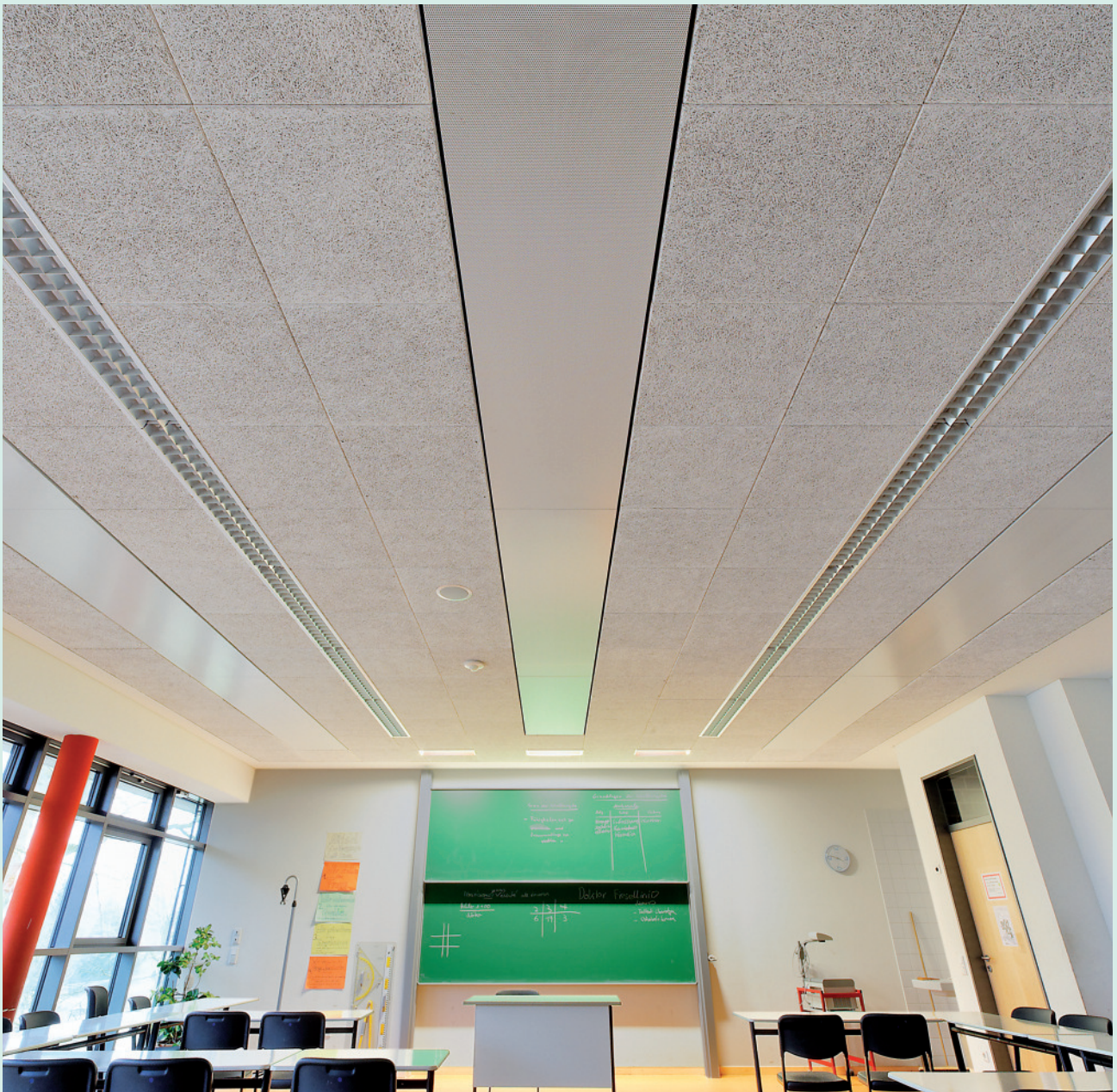
Einsatzbeispiel: Schule Gronau
